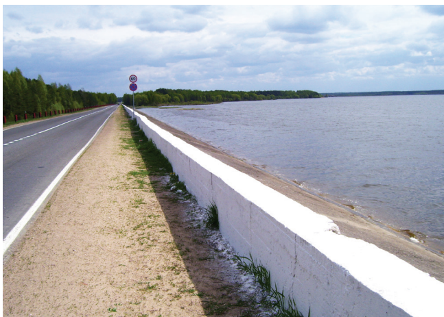
Рис. 1. Бетонное крепление откосов. Вилейское водохранилище
