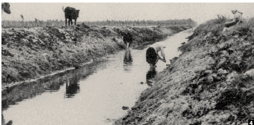
Рис. 4. Вырытый лопатами осушительный канал
