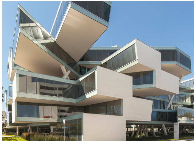
Рис. 2. Здание бизнес-центра Actelion (Herzog & de Meuron, Альшвиль, Швейцария, 2010)
