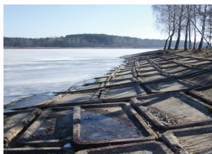
Рис. 3. Характерные разрушения крепления откосов
