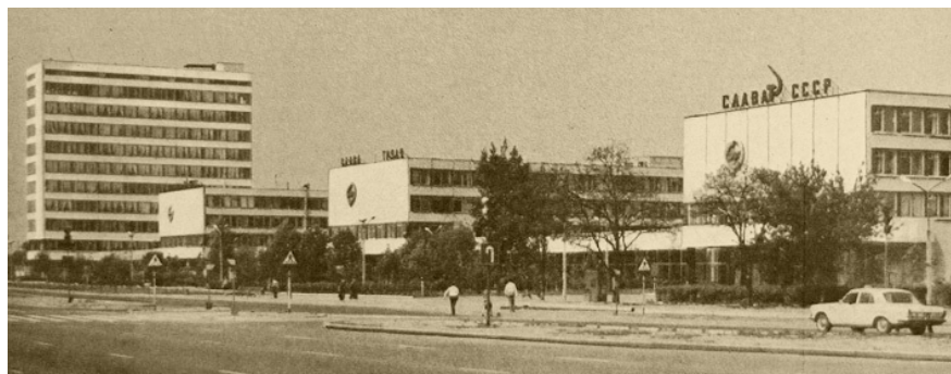
Рис. 7. Корпуса Брестского электромеханического завода в 1970-е гг.
