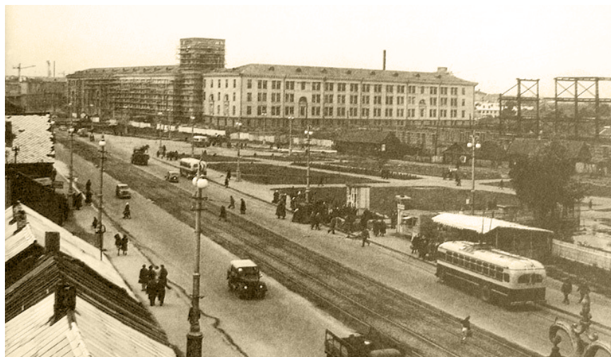
Рис. 5. Строительство Минского завода математических машин (металлический каркас справа от Полиграфкомбината, возведение которого близится к завершению). 14 сентября 1956 г.
