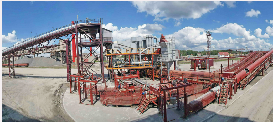
Рис. 18. Технологическая линия получения щебня узких фракций
