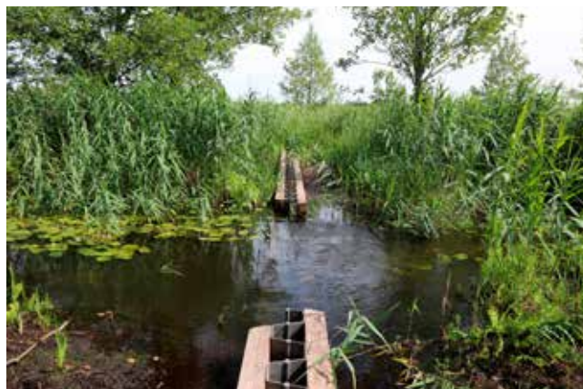
Рис. 4. Переливная русловая плотина из пластикового шпунта на низинном болоте Сервечь, используемая для оптимизации гидрологического режима
