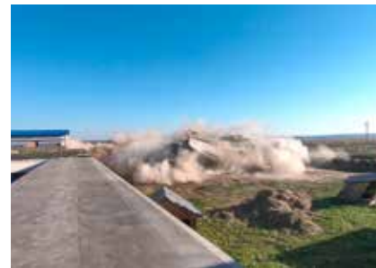
Взрывной монтаж аварийного здания в Оршанском районе
