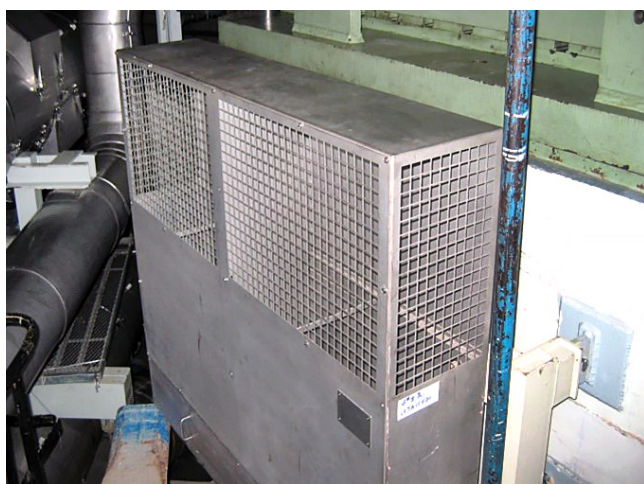
Рис. 4. Рекомбинатор водорода
