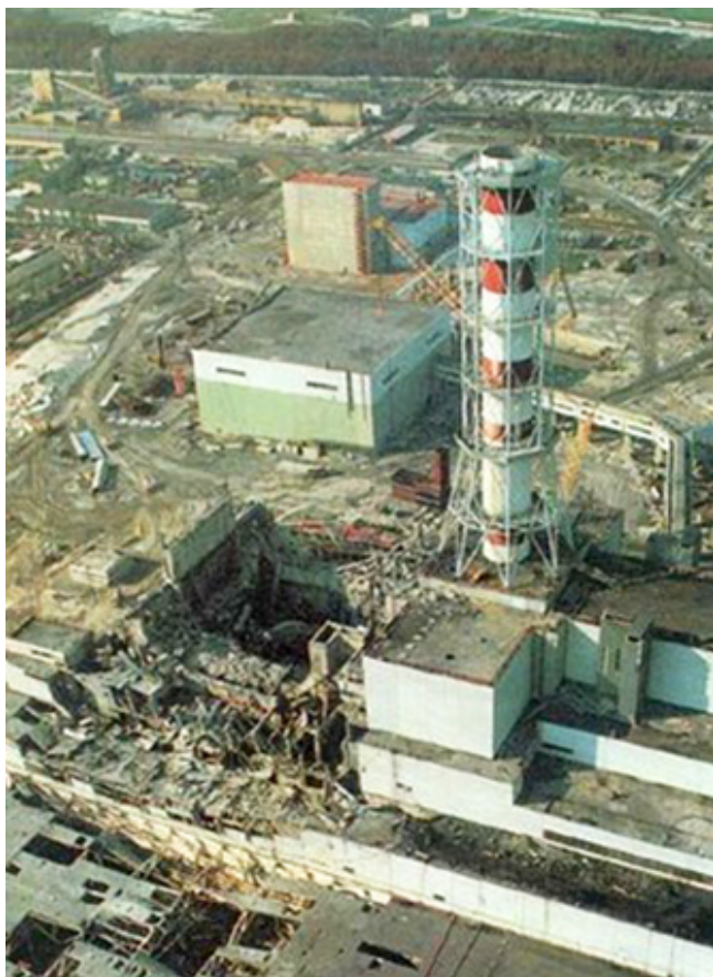
Рис. 2. Эпицентр трагедии. Разрушенный энергоблок Чернобыльской АЭС
